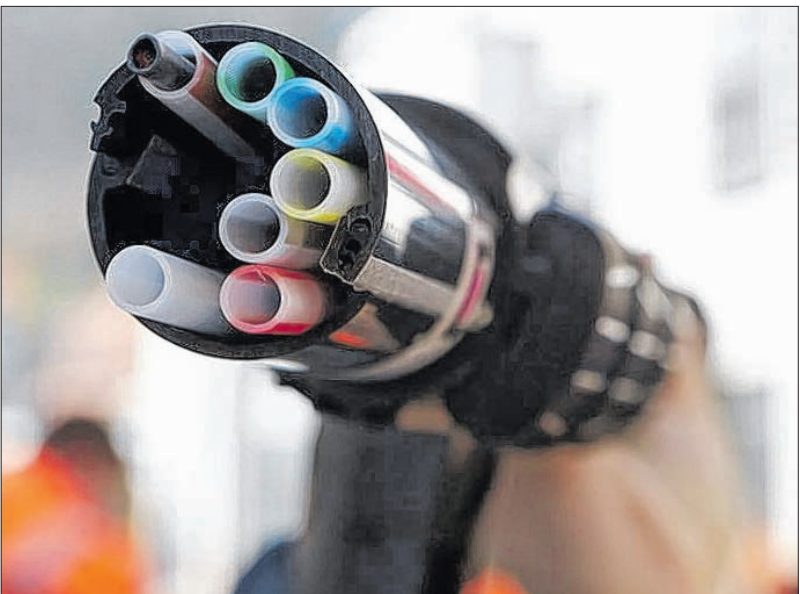
Das Rohr für VDSL-Kabel, das die Telekom jetzt in Kirchenkirnberg verlegt hat, womit sie für ein schnelleres Internet im Ort sorgt. Privatfoto
