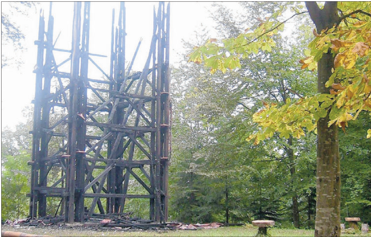
Die Ruine des Riesbergturms kurz nach dem Brand im September 2008; der Turm wird wieder aufgebaut. Foto: Bergmann
